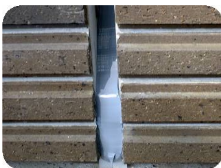
②下地シールの施工
