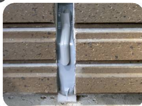
③水抜きパイプの設置
