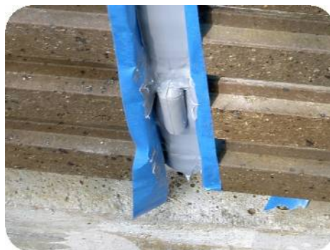
⑤目地のシーリング仕上げ
