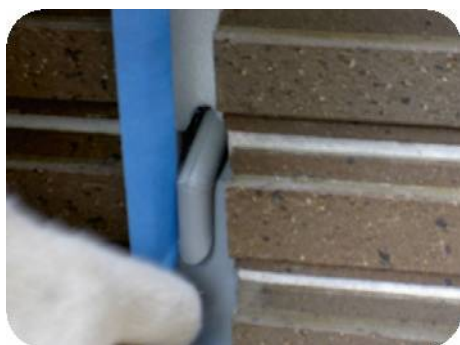
④上部にバックアップの設置
